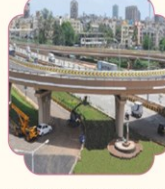
MAINTENANCE OF ROADS, BRIDGES, FLYOVERS सड़कों, पुलों, फ्लाईओवरों का रखरखाव
