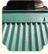
MAINTENANCE OF ROOFTOPS छतों का रखरखाव
